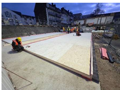
Blick in die Baugrube: Die Betriebsgänge inklusive der Treppenzugänge sind hergestellt, das Messsystem zur Überprüfung der Abbrucharbeiten ist installiert.
