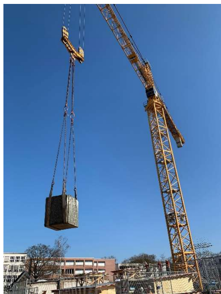
Im mittleren Bereich der Baugrube (Block 2) werden die Abbrucharbeiten der Decke mittels Sägeschnitten durchgeführt. Sobald ein Betonklotz ausgesägt worden ist, wird dieser aus dem Loch gehoben und anschließend mit Hebebändern auf das Baufeld Ost gehoben. Dort wird der Betonklotz dann zeitnah für den Abtransport zerkleinert.
