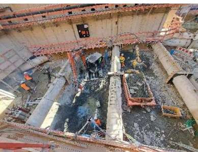
In der Baugrube laufen die Abbrucharbeiten der Decke mittels präziser Sägeschnitte. Rund 20 Betonklötze konnten bereits geborgen werden. Nach dem Ausheben werden die Quader auf das Baufeld Ost transportiert, dort mit Kernbohrungen und Spaltzylindern geräuscharm zerkleinert und anschließend abtransportiert.
