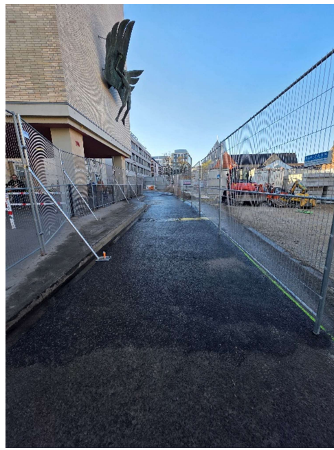
Die neue Radwegführung musste an den bestehenden Fußgängerweg angepasst und ein entsprechender Niveaueausgleich geschaffen werden.
