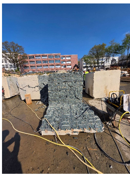
Die Abbrucharbeiten gehen gut voran. Um die einzelnen, beengten Felder in der Baugrube abarbeiten zu können, müssen die eingesetzten Baumaschinen immer wieder umgesetzt werden (Fotos oben und unten links). Die aus der Decke ausgesägten Betonklötze werden auf dem Baufeld für den späteren Abtransport geräuscharm zerkleinert.
