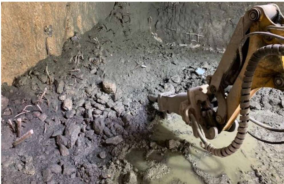
Links: Abbruch der stahlbewehrten Betondecke im Norden des Gleiswechselbauwerks. Rechts: Vorgefertigte Bohrlöcher für die Verankerung der Stahlaussteifung.
