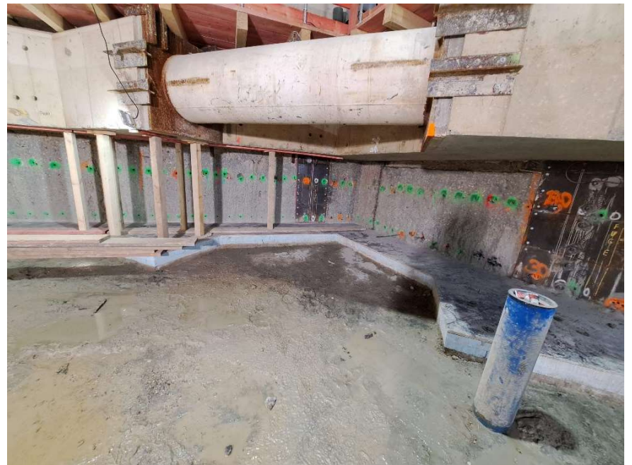
Links: Abbruch der stahlbewehrten Betondecke im Norden des Gleiswechselbauwerks. Rechts: Vorgefertigte Bohrlöcher für die Verankerung der Stahlaussteifung.
