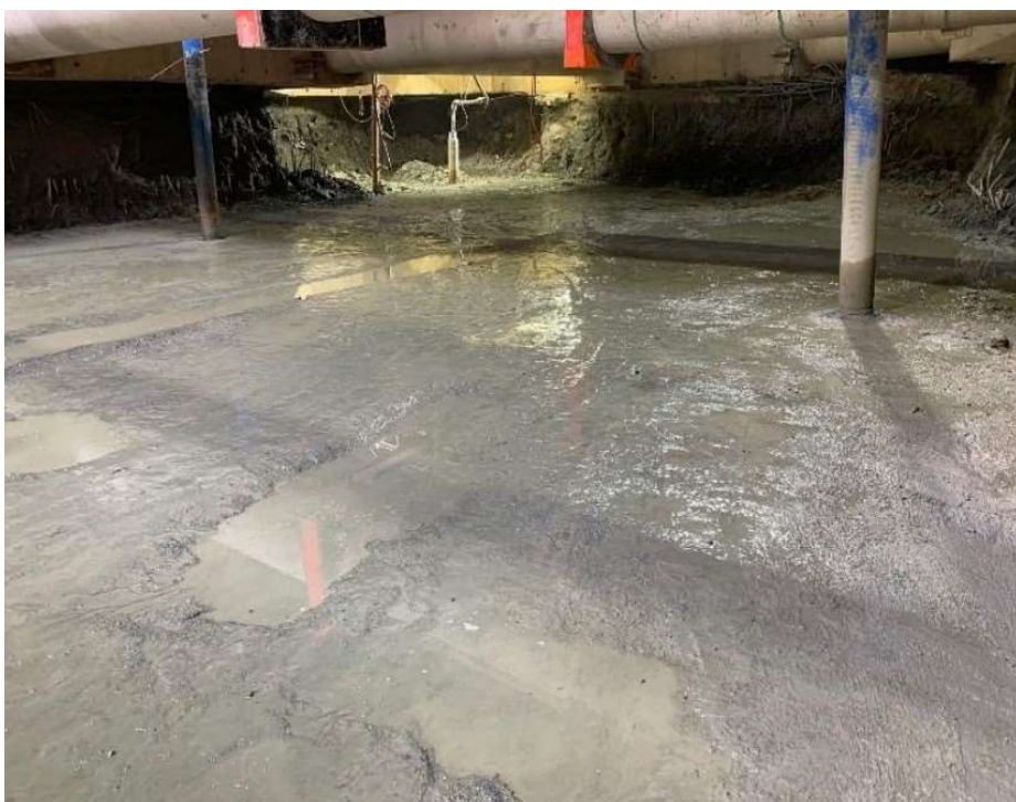
Herstellung einer ebenen Arbeitsfläche nach dem Abbruch der Betondecke.
