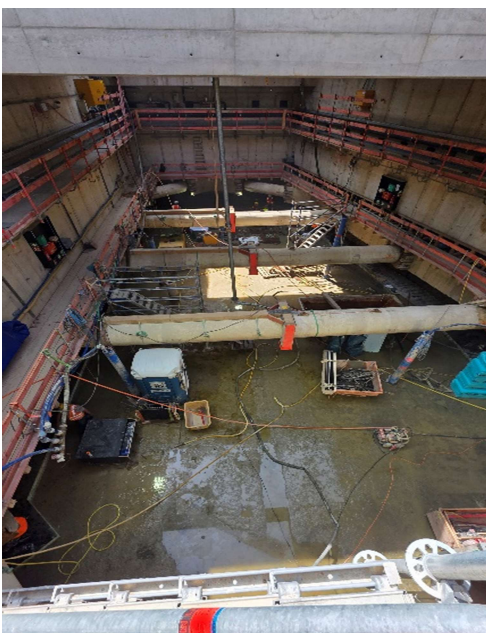
Blick in die Baugrube: Jede Steifenlage, die für Stabilität des Bauwerks sorgt, besteht aus 16 Stahlrohren. Im rechten Bild sind die restlichen Arbeiten zum Abbruch der alten Decke zu erkennen.
